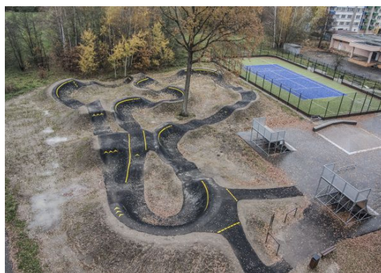
pumptrack z asfaltu není propustný pro srážkové vody, je ale hladký a z hlediska nákladů a údržby optimální, lze využít také
